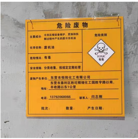
危废间内标志牌
