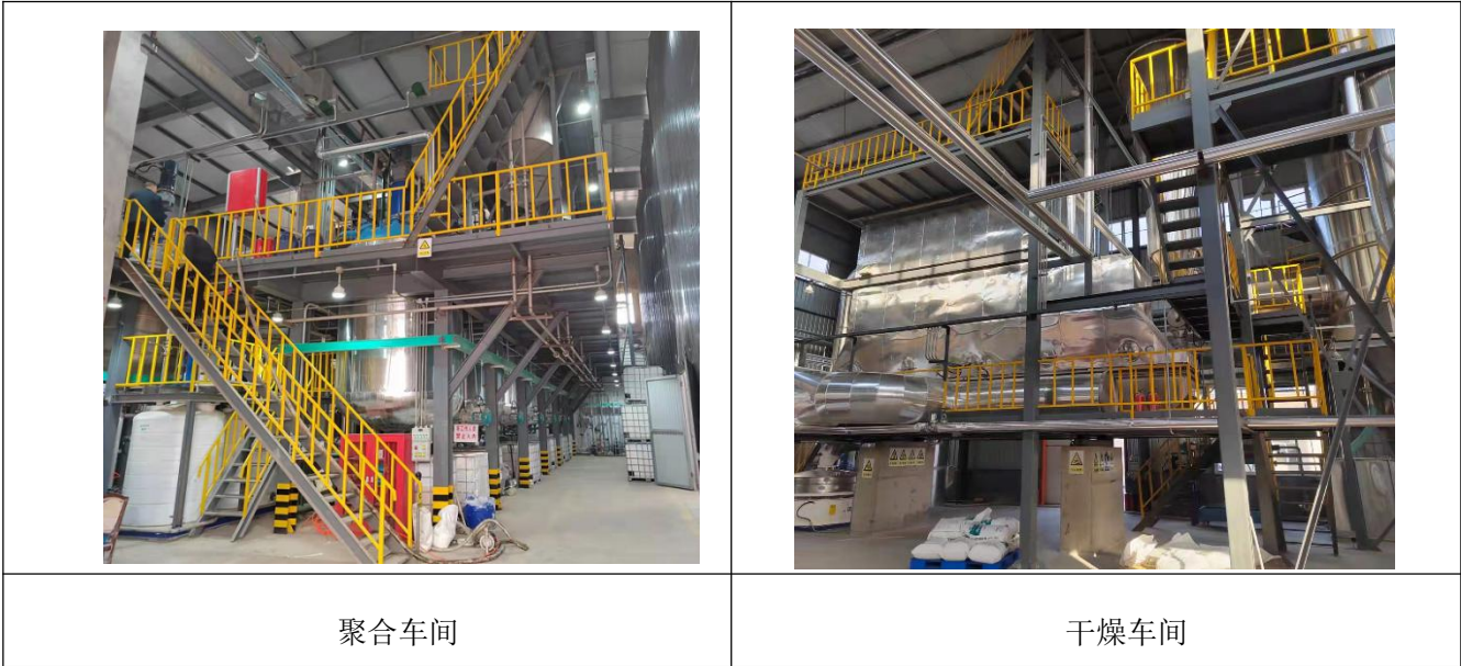
图 3-4 项目车间实际建设情况
